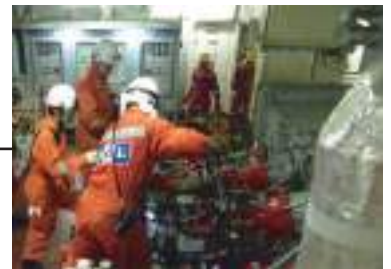
せいびちゆう ボイラ整備中
